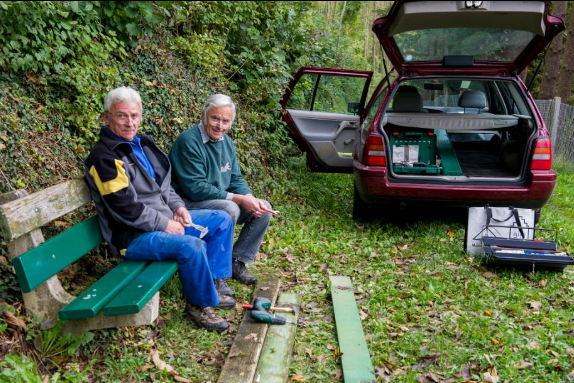
Montage am Summerhaldenweg 15. Oktober 12
