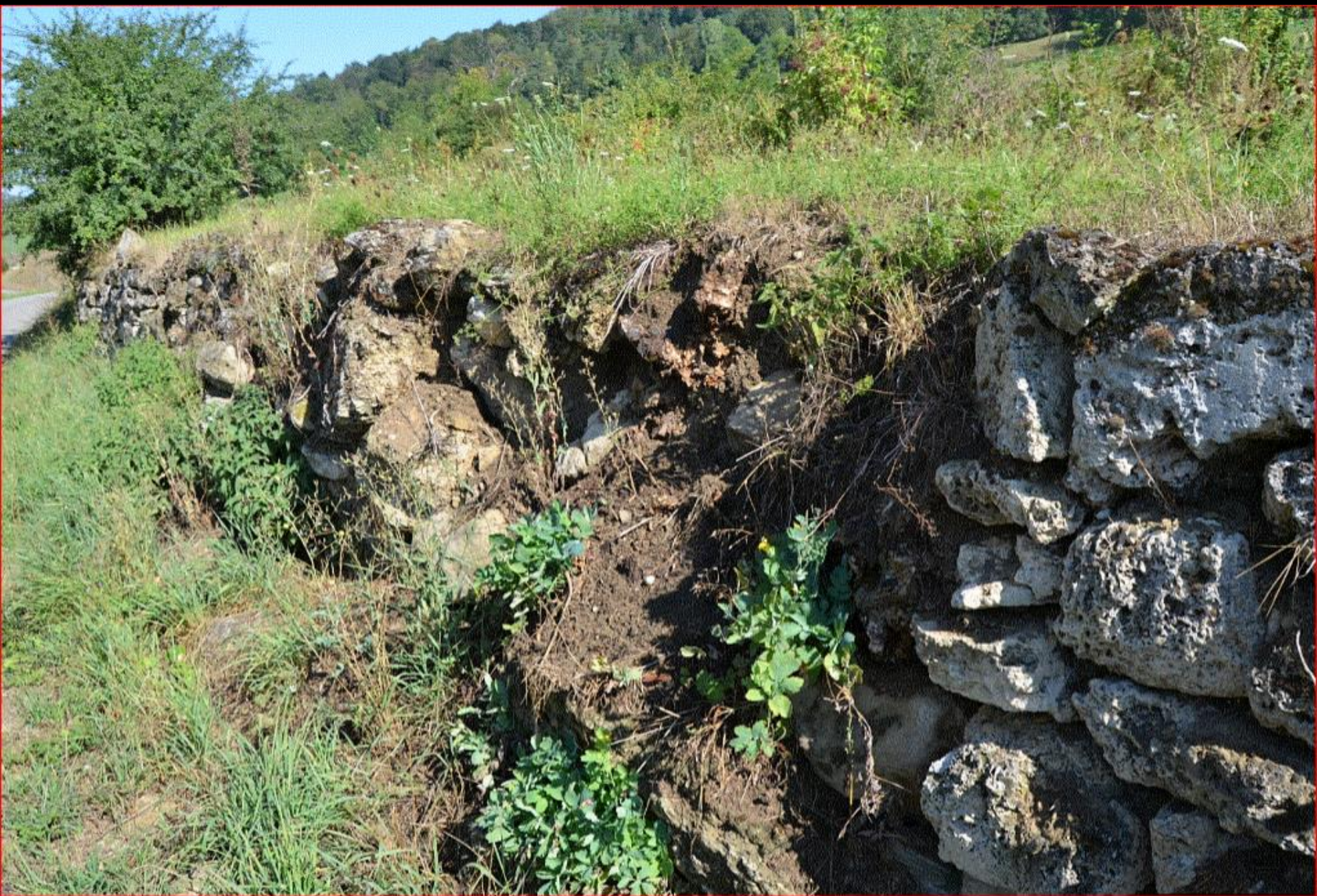
Tuffsteinmauer – Burgstrasse Freienstein 15. August
