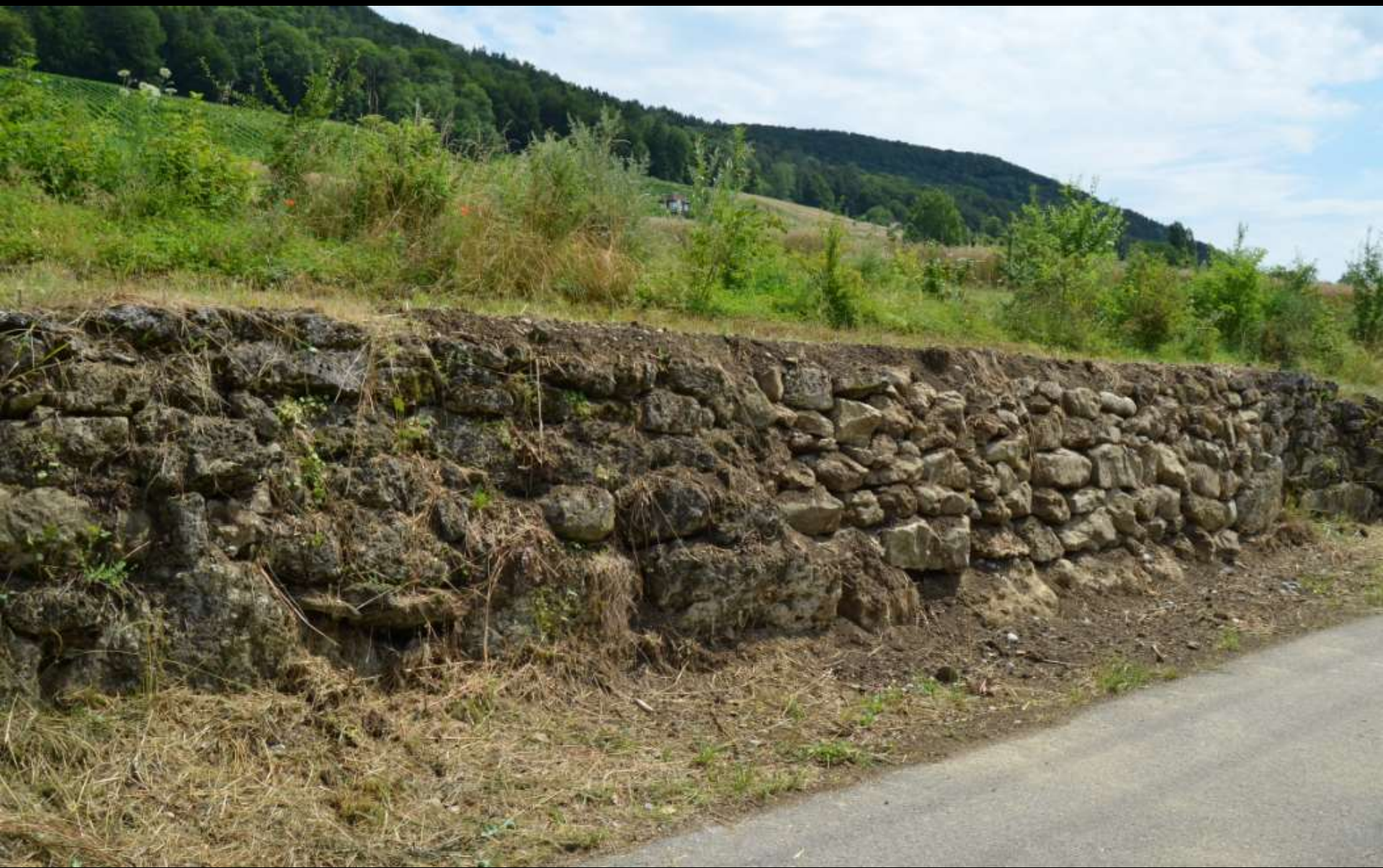
Reparierte Steinmauer am Burgweg 7. Juli
